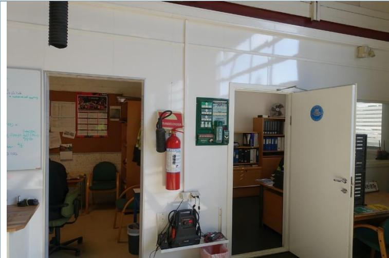
Bilde 1: Skilt for håndslokker festes til veggen.
