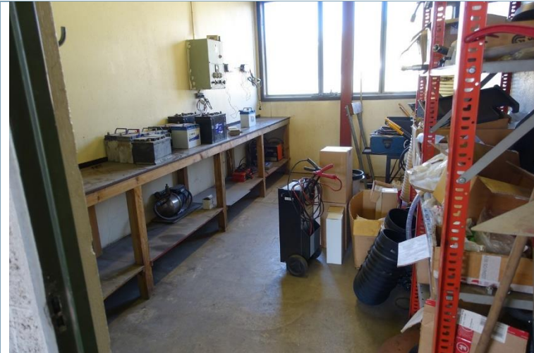
Bilde 4: Lading av batterier som utvikler knallgass.
