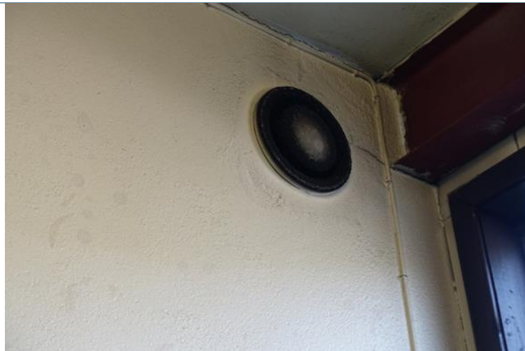
Bilde 5: Avtrekk fra laderom må kontrolleres for funksjon
