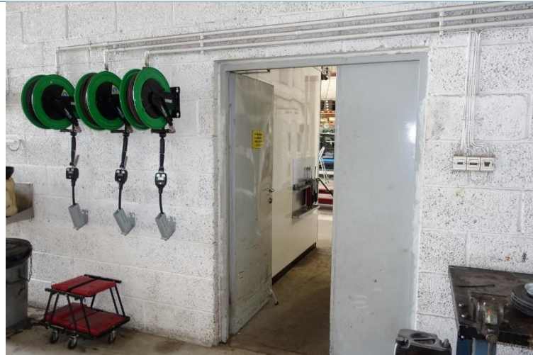
Bilde 7: Selvlukkende dører holdes åpne i daglig drift. Må holdes lukket eller holde åpne med dørholdermagneter som lukker ved røykdeteksjon i området.
