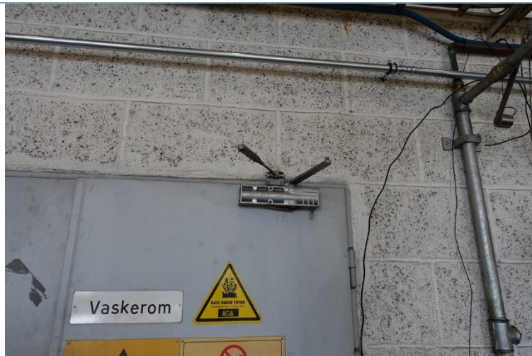
Bilde 2: Selvlukkere må kobles på slik at de virker som forutsatt.
