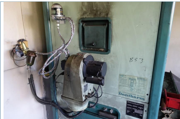
Bilde 13: Varmluftaggregater må kontrolleres og ha serviceavtale.
