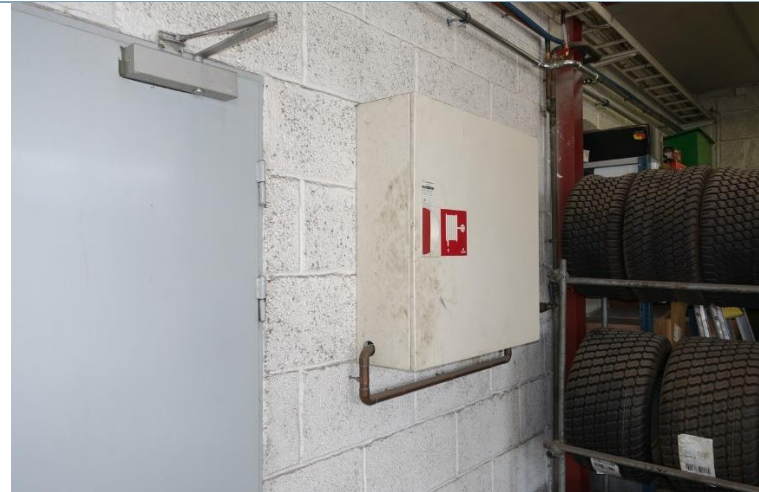
Bilde 10: Brannslangeskap skal være synlig også i ferdselsretningen. Plogskilt monteres over skapet.
