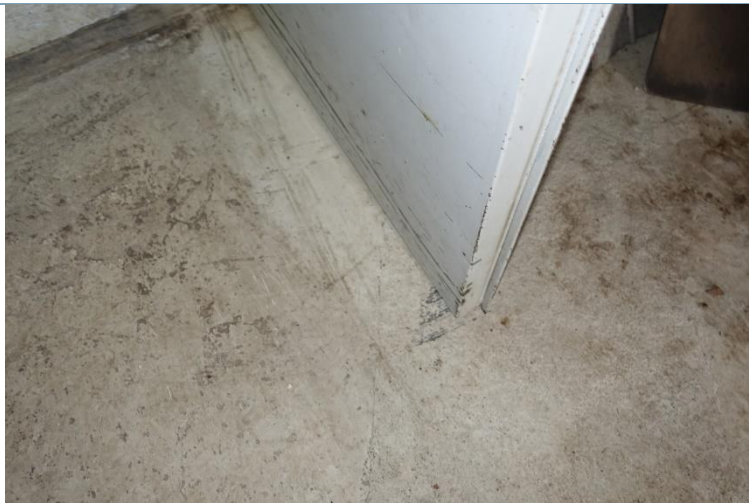
Bilde 8: Dører må justeres slik at de åpner og lukker som forutsatt.
